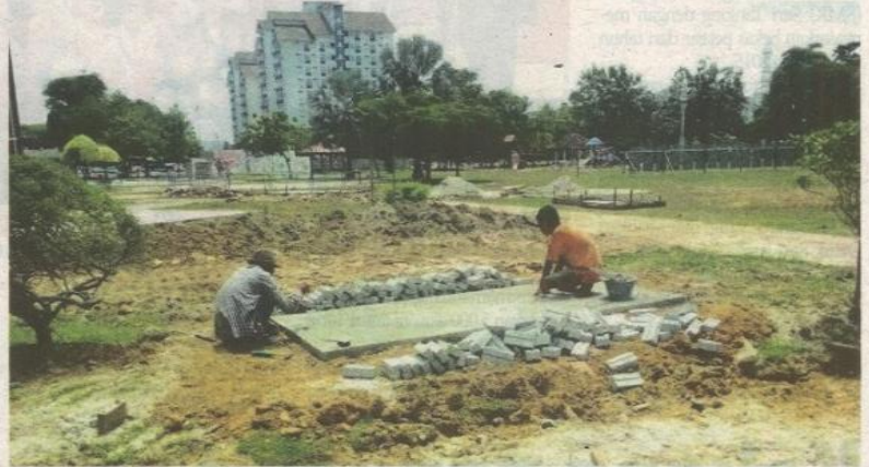
Kerja-kerja pembinaan pelbagai kemudahan fasa ketiga sedang dijalankan.
